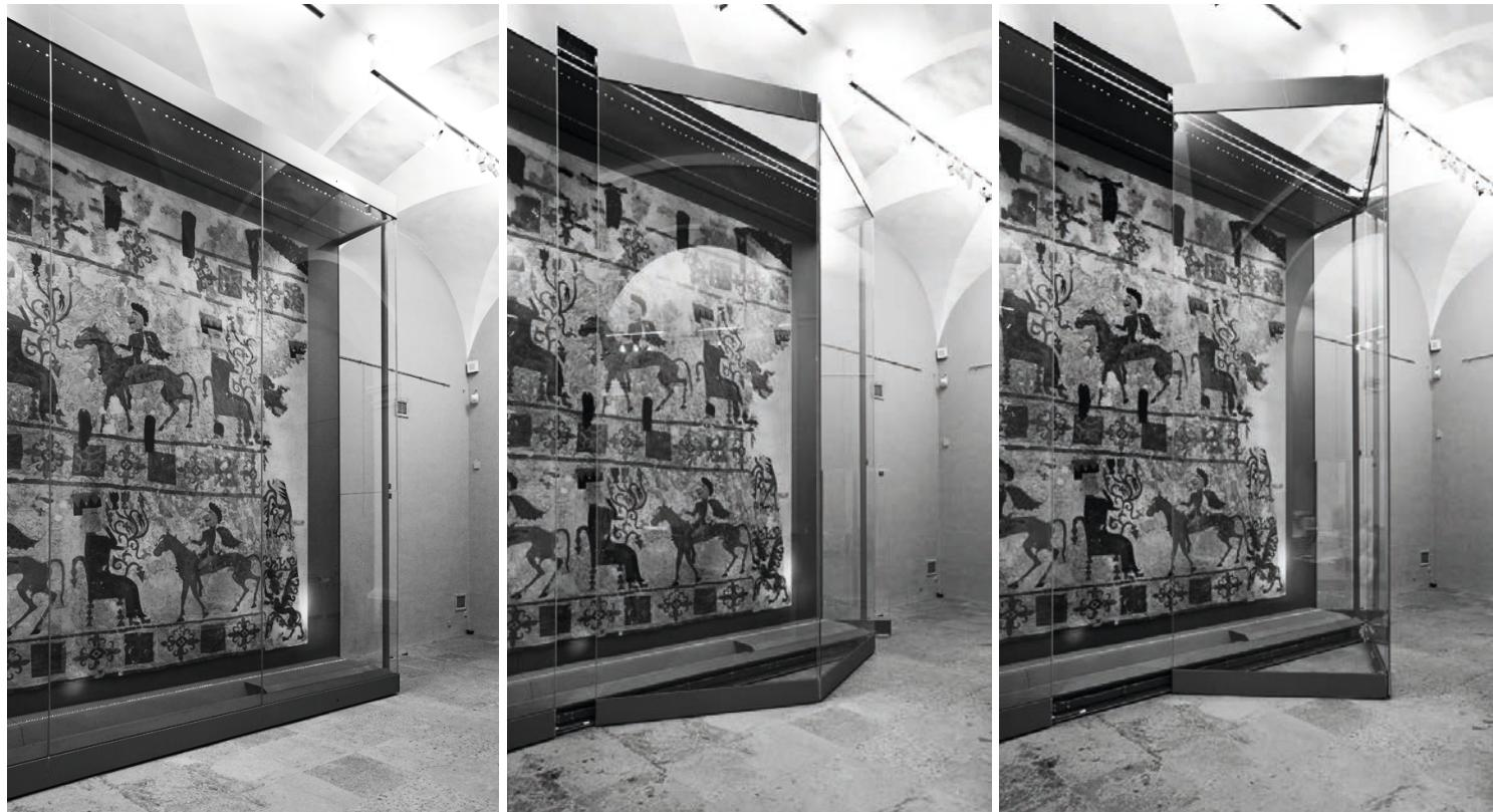
Die Vitrinenfront lässt sich nahezu vollständig öffnen, so dass der fest auf einem Halterahmen arrierte Teppich ohne Verformung entnommen werden kann. Die Vitrine verfügt zu diesem Zweck über eine eigene Vorrichtung zum Herausschwenken des Teppichs. Die Vitrine garantiert im geschlossenen Zustand die geforderte Dichtheit und beinhaltet trotz ihrer enormen Größe keine die Sicht in irgendeiner Weise beeinträchtigende Stützkonstruktion.
